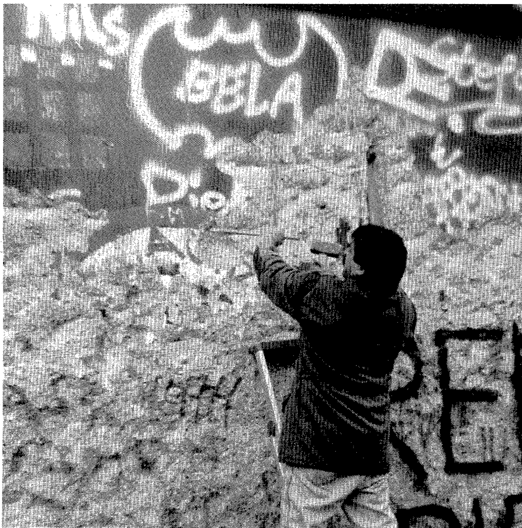
El muro de Berlín, en fase de derribo
